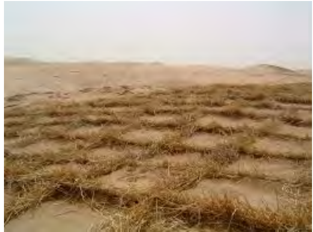
FIGURE 1.10 – Dunes de sable recouvertes par des damiers de paille. L'insertion de paille de manière périodique dans le dunes permet de les stabiliser et empêche ainsi leur progression (Bannière de Naiman, Mongolie intérieure, Chine) (© Li Chunying).
